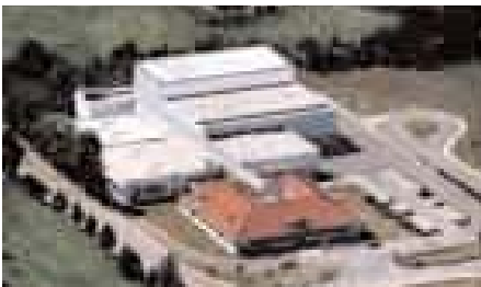
Das 1997 neu gebaute Aeropharm Werk in Rudolstadt liegt direkt neben dem alten Grundstück des 1876 gegründeten Unternehmens. Ein On-Line-Monitoring-System von Lufft sorgt jetzt für modernsten Produktionsstandard. The Aeropharm factory in Rudolstadt, newly built in 1997, lies directly alongside the original site of the Company, which was founded in 1876. An online monitoring system by Lufft now provides for state of the art production standards.
