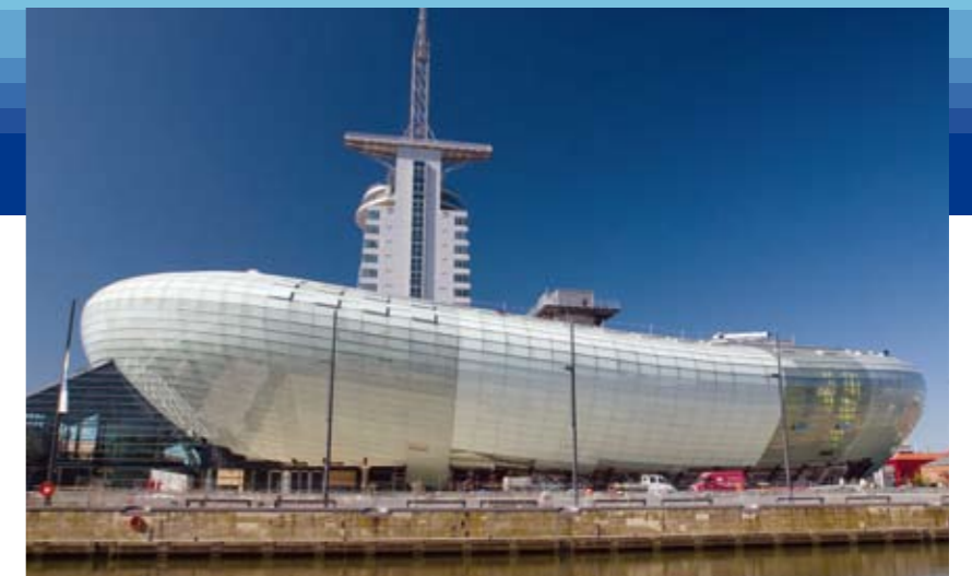
Ein Gebäude mit acht Klimazonen.
