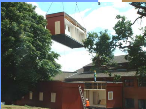
Zusammenfügen eines Modularen Reinraums, NIBSC
